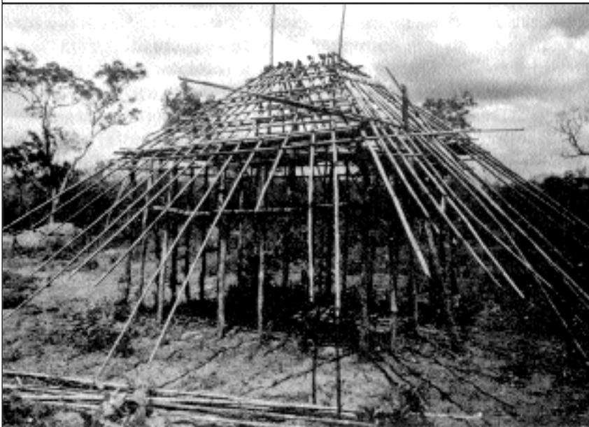
La struttura in bambù di una abitazione, Mozambico settentrionale.
